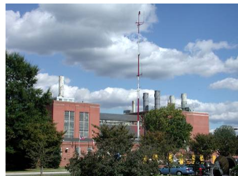
UM Energy Plant
